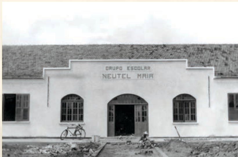
Construção do Grupo Escolar Neutel Maia, em Rio Branco, na década de 1950. Fonte: Acervo DPHC - FEM.
